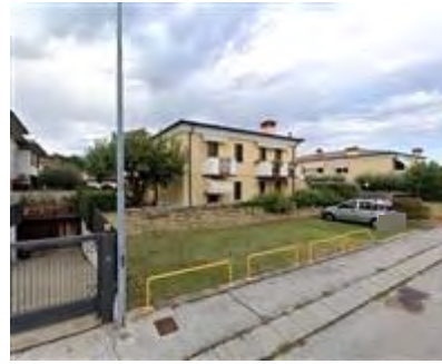
Vista da Ovest da via Cavallare
