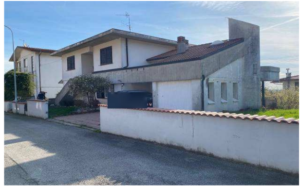
Vista esterna da nord-ovest
