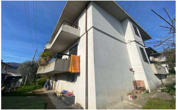
Vista esterna da sud-est
