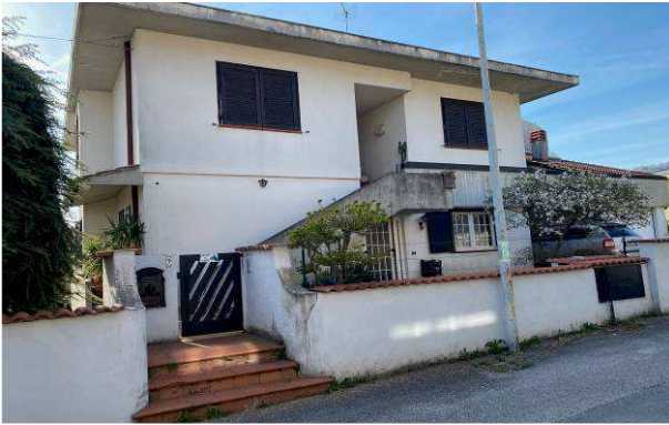
Vista esterna da nord-est
