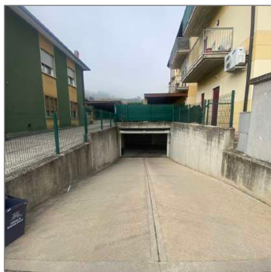
Rampa comune di accesso all'interrato
