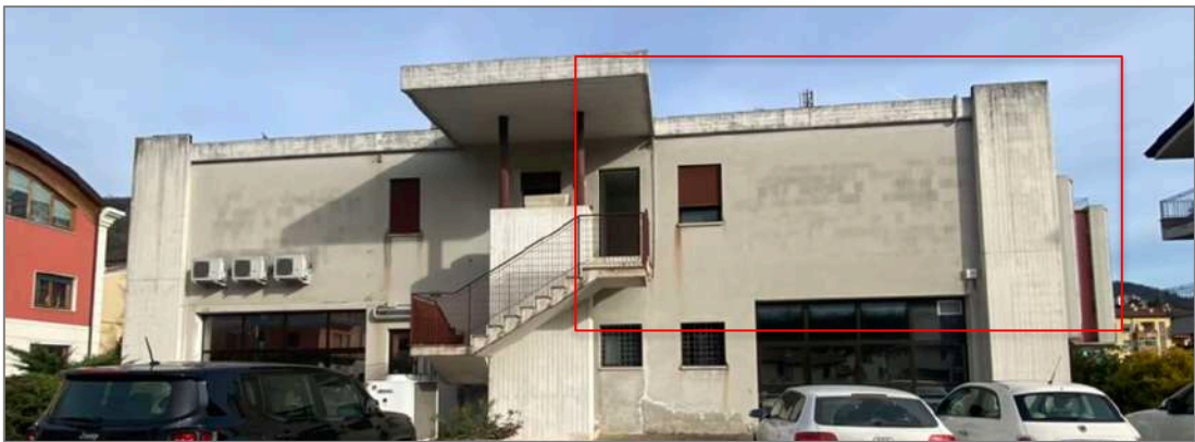
Scala di accesso al piano primo
