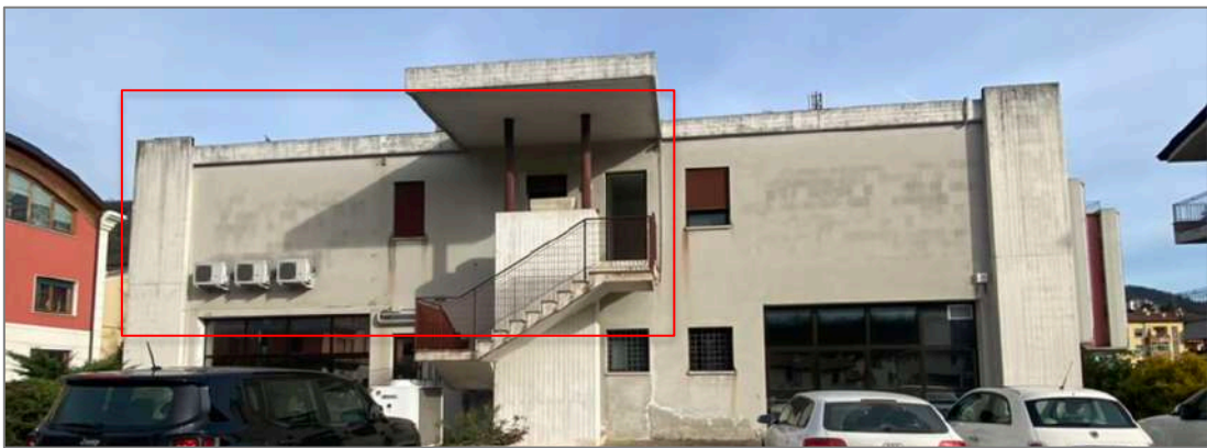
Scala di accesso al piano primo
