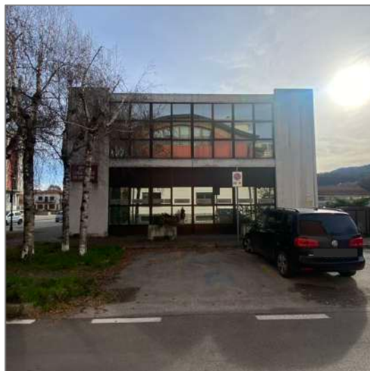
Vista da Via Trento - fronte Nord
