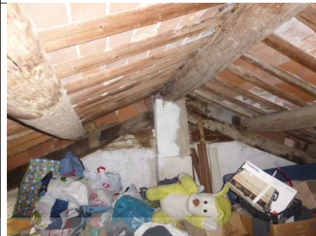
Foto 12: VISTA INTERNA: SOFFITTA
