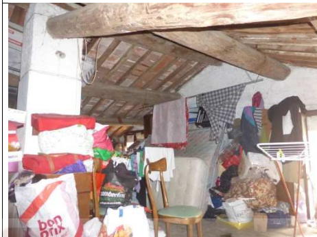
Foto 11: VISTA INTERNA: SOFFITTA
