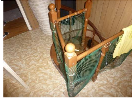
Foto 9: VISTA INTERNA: DISIMPEGNO
