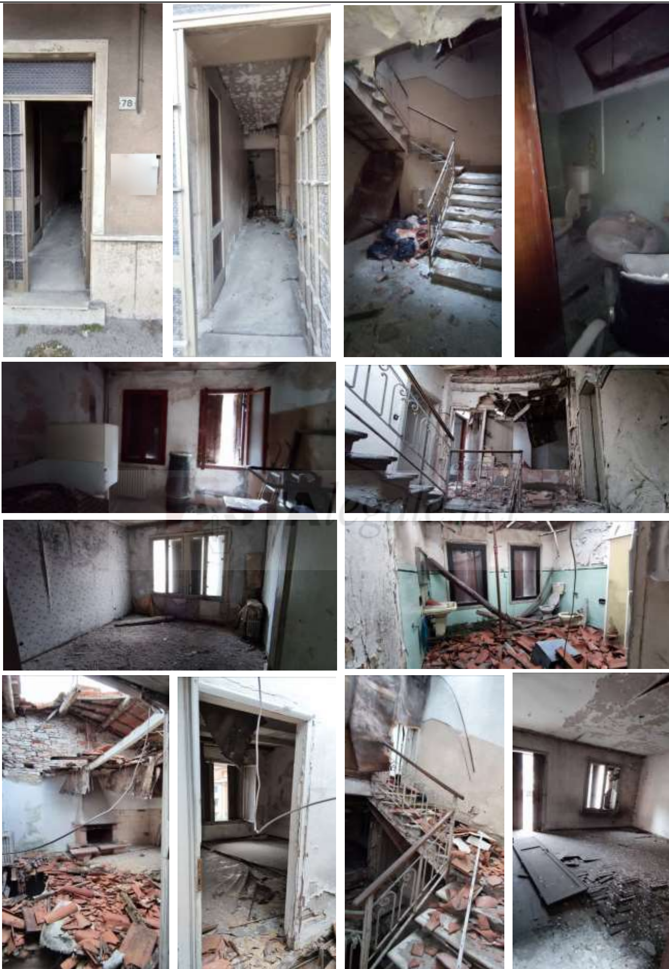
Foto n. 6: a)->n) vista interna Corpo C dal PT a P2
