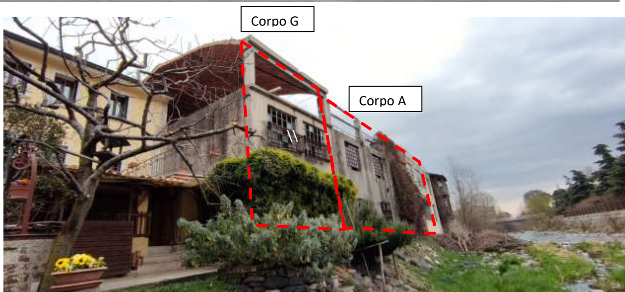
Foto n. 1 a)-b)-c) : vista da Via Pace Sud-Ovest e Nord-Est e da Sud-Ovest
