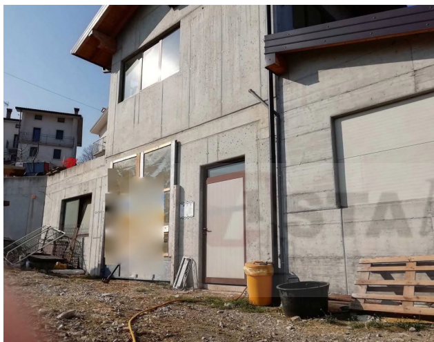
Vista sud – entrata stalla
