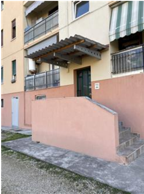
Vista sul portoncino di ingresso condominiale.
