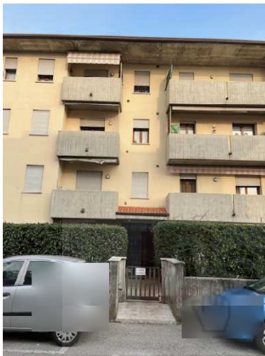
Esterno - entrata condominio
