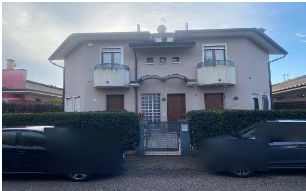
Vista esterna da nord
