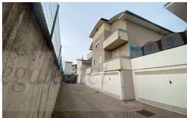
Vista esterna area di manovra autorimesse
