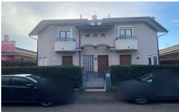
Vista esterna da nord
