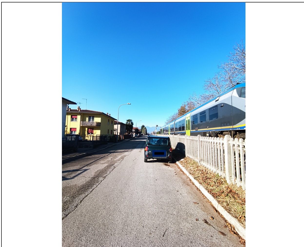
Foto n 2 – fabbricato condominiale/ferrovia
