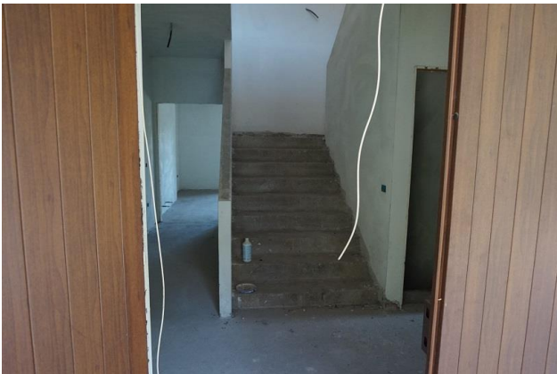
Piano Terra –Atrio ingresso da ovest verso est
