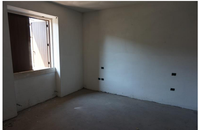
Piano primo – Camera a nord/ovest
