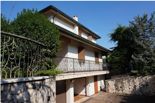
Fronte sud da rampa accesso carraio
