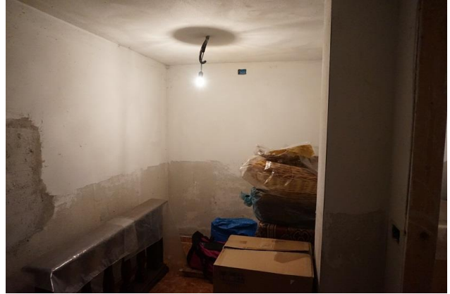
Piano interrato – Cucinotto da est verso ovest
