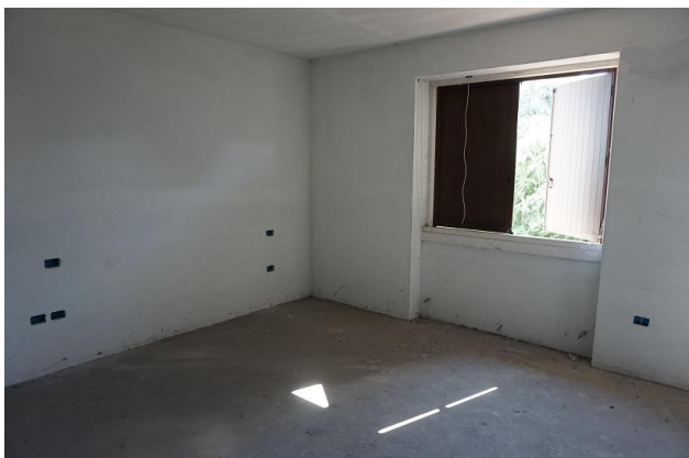
Piano primo – Camera a sud
