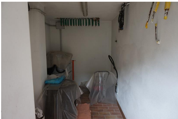
Piano interrato – Centrale termica
