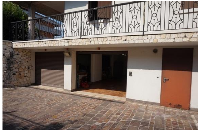
Ingressi autorimesse da corsia manovra a sud
