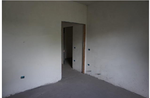
Piano terra – Porta tra soggiorno e corridoio
