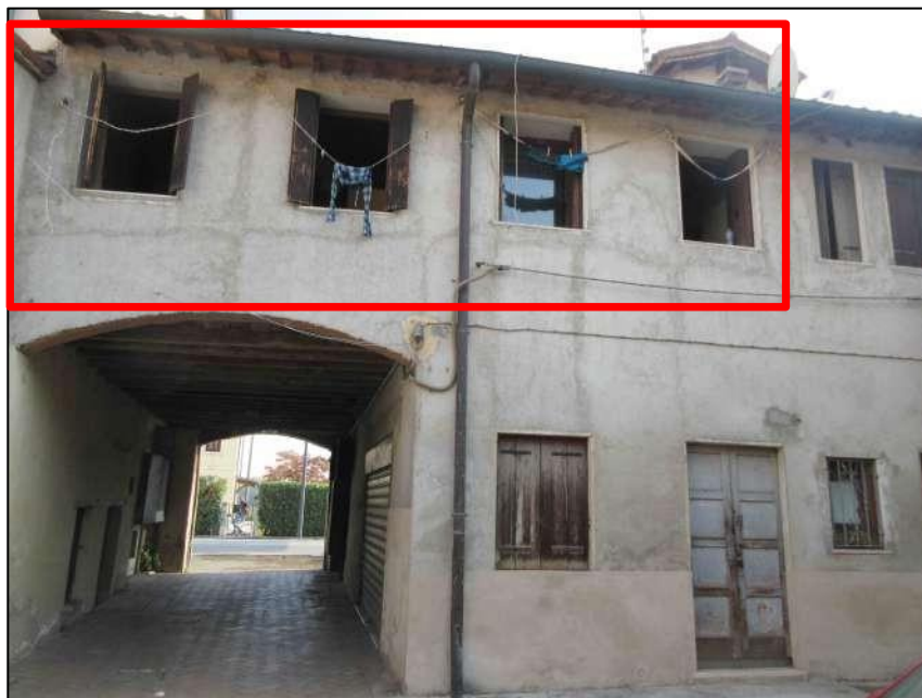
foto del fabbricato dal cortile interno
