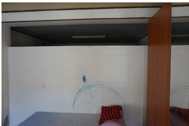
Piano terra – Parete divisoria stanze ad est
