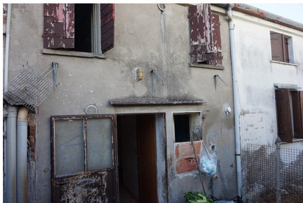
Fronte nord unità abitativa da corte esclusiva
