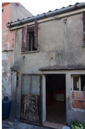
Fronte nord unità abitativa da corte esclusiva
