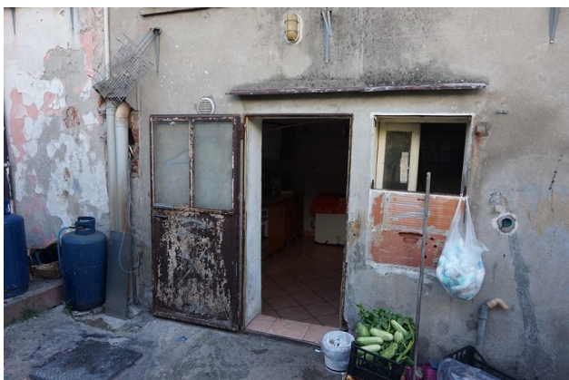
Fronte nord unità abitativa da corte esclusiva
