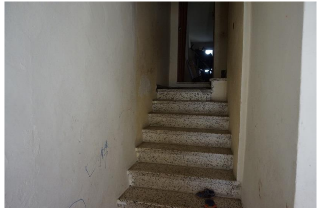
Piano terra – Particolare scala interna
