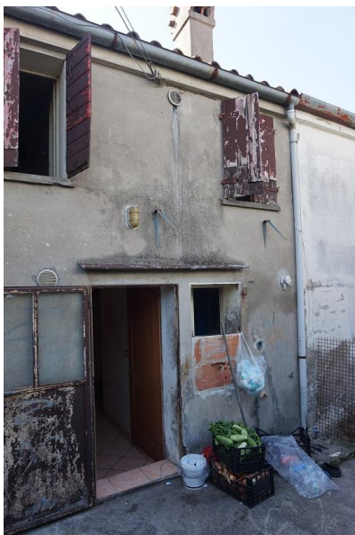
Fronte nord unità abitativa da corte esclusiva
