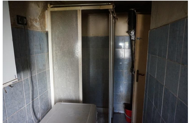
Piano primo – Bagno da nord verso sud
