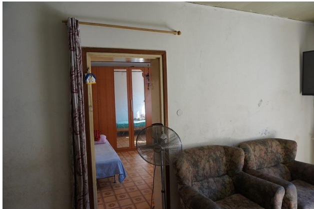
Piano terra – Zona ingresso con accesso stanza a sud/est
