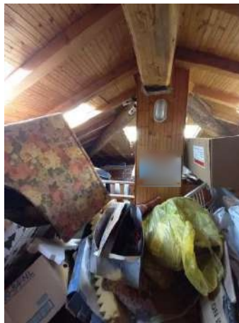
VISTA SOFFITTA 3°P
