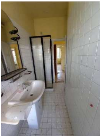
VISTA BAGNO 2°P
