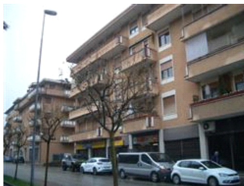
Vista generale da Sud-Ovest
