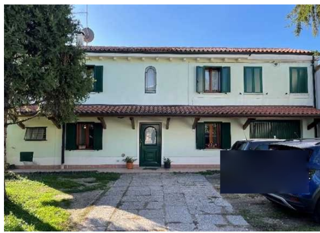
Vista del fabbricato da Nord
