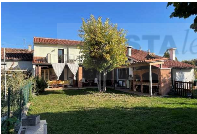
Vista del fabbricato da Sud
