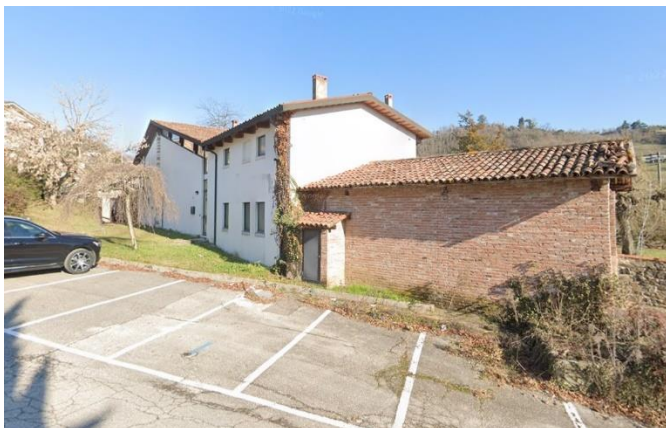
Vista del fabbricato da Sud Ovest
