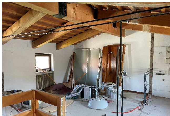
Vista del sottotetto ex locale uffici
