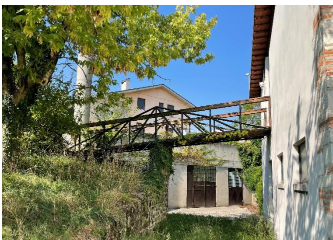
Vista della passerella di collegamento con il soppalco
