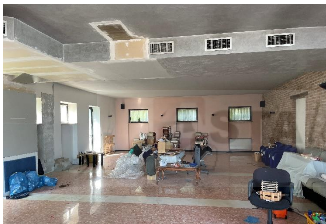
Vista interna della sala bar (pranzo) al piano terra
