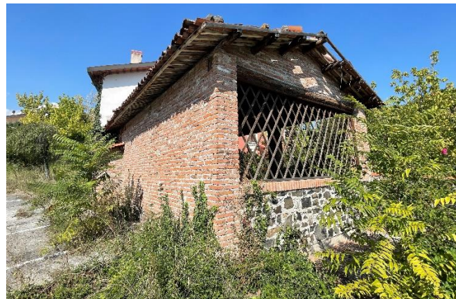
Vista del lato Sud
