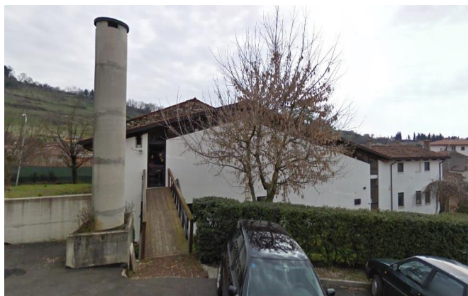
Vista del lato Ovest del fabbricato ad uso commerciale
