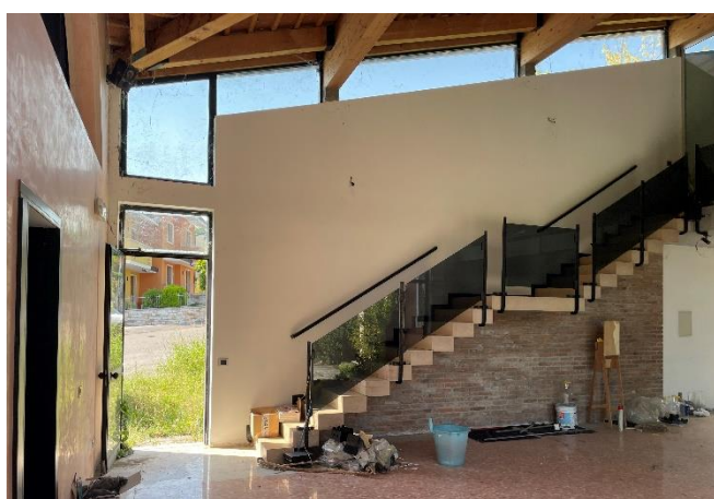
Vista della rampa scale di collegamento con il soppalco
