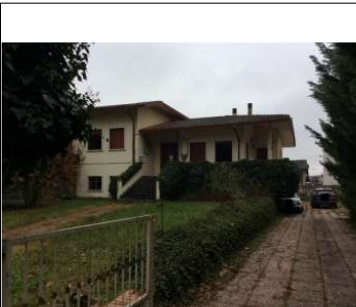
Foto 1: Esterni: fronte principale
