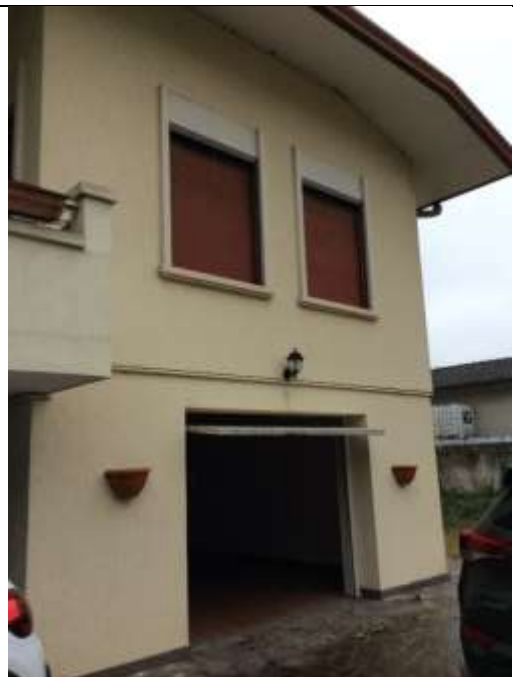
Foto 2: Esterni: fronte laterale e ingresso garage
