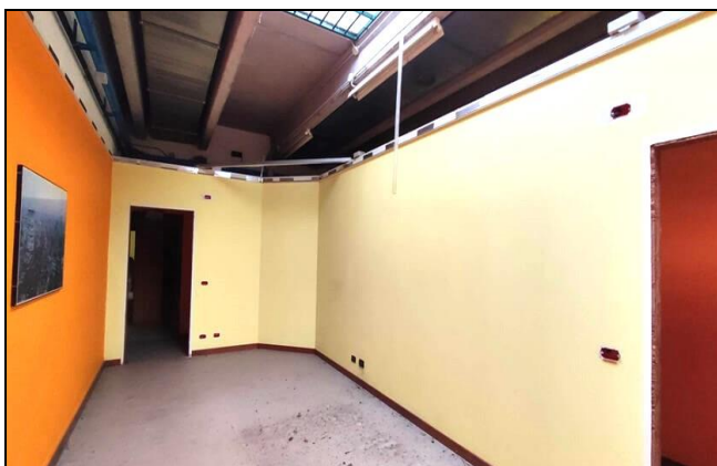
Stanza 18 – controsoffitto e porte asportati
