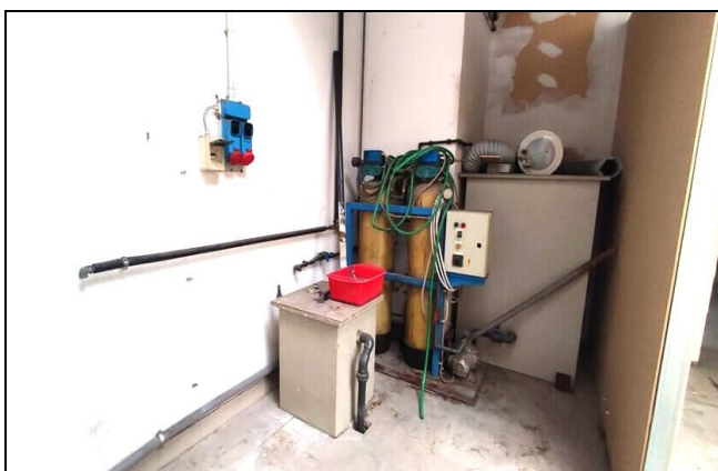
Stanza 20 – ex depurazione acque
