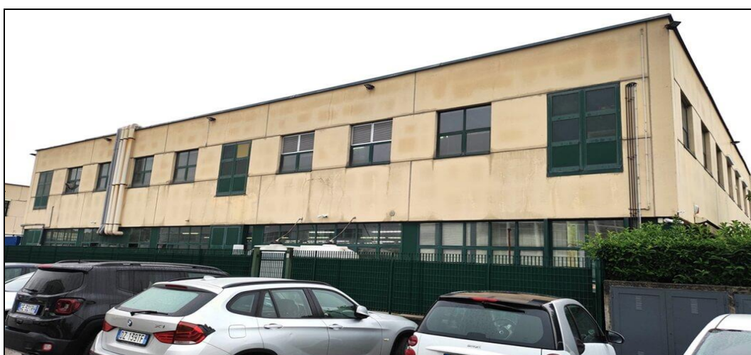
Vista facciata lato nord del complesso immobiliare
