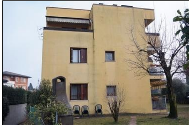
foto 2 - Edificio condominiale facciata ovest
