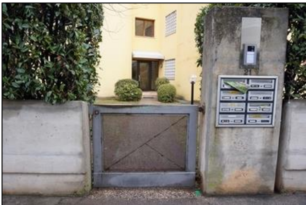
foto 3 - Ingresso condominiale pedonale
