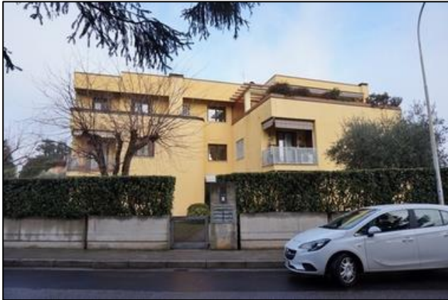
foto 1 - Edificio condominiale facciata sud
