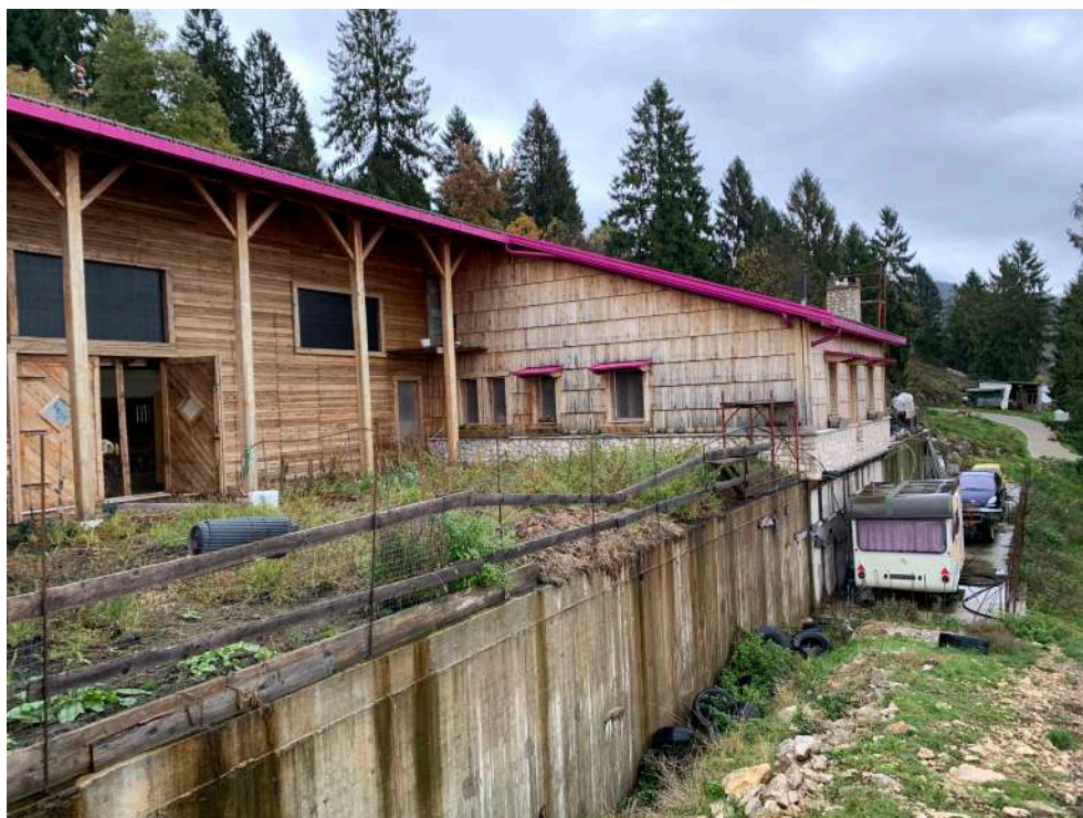
Malga, vista del fronte sud.
