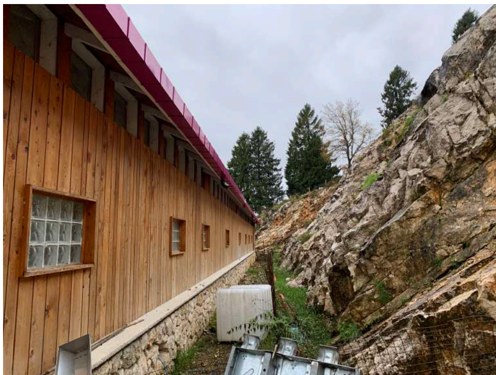
Malga, vista del fronte nord.
