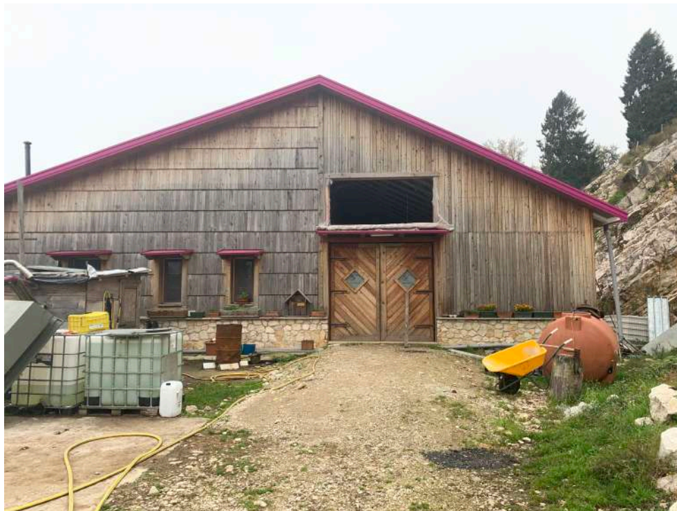
L'edificio principale (malga), vista del fronte est.
