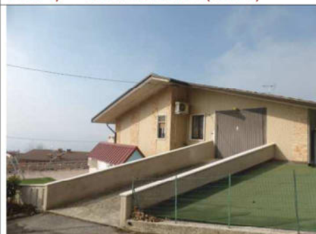
Foto 3) VISTA ESTERNA (lotto 7)
