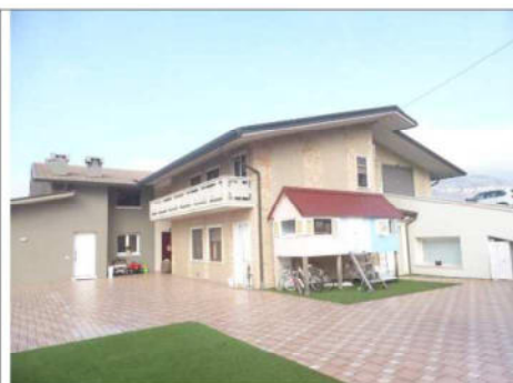
Foto 1) VISTA ESTERNA (lotto 7)
