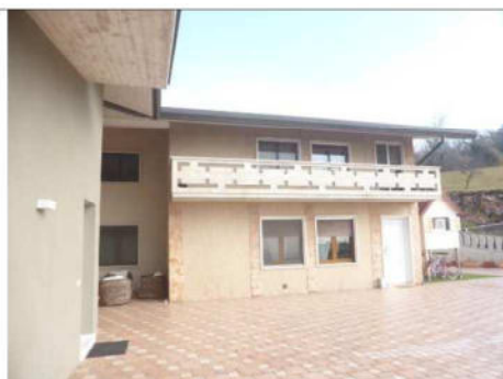
Foto 2) VISTA ESTERNA (lotto 7)
