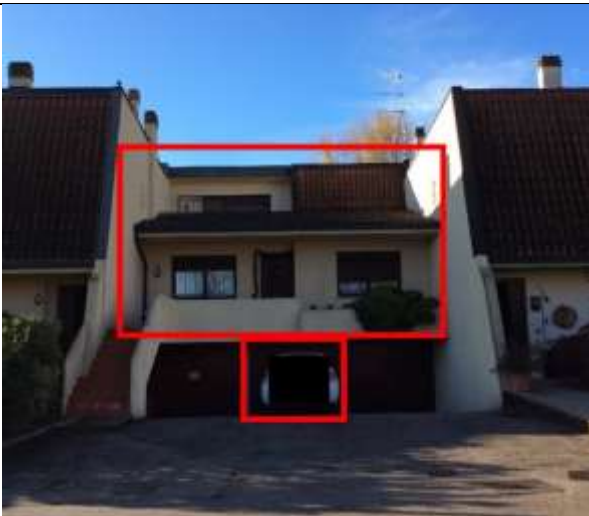
Foto 1: Vista lato anteriore: in rosso l'abitazione ai piani terra e primo e il garage al piano interrato
