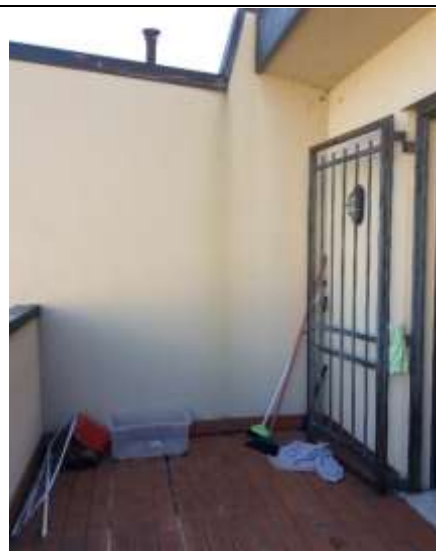
Foto 12: P1 - Terrazzo con accesso da sottotetto
