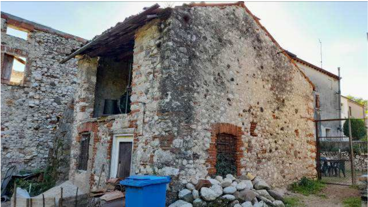
Figura 11. Vista nord-ovest, p.lla 1949.
