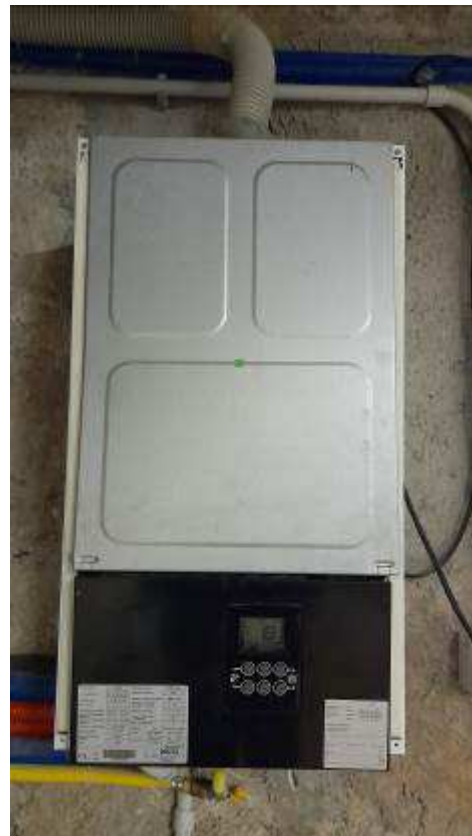
Figura 15. Caldaia in cantina.
