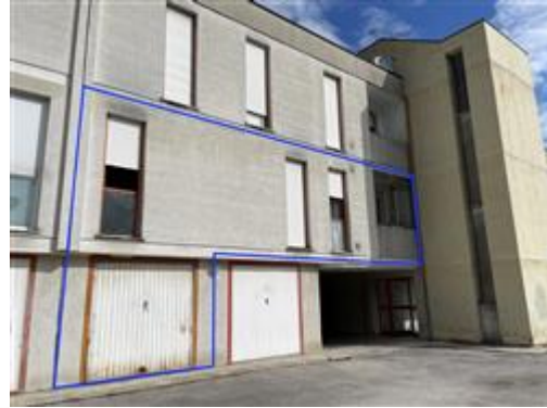
Vista esterna del condominio sa sud (contorni indicativi sull'unità in oggetto).
