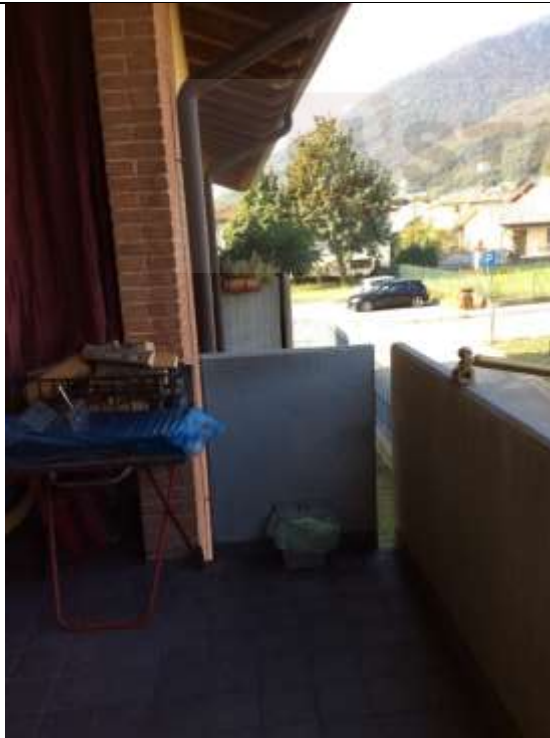
Foto 13: P1: Poggiolo lato nord-ovest
