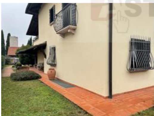
- Veduta generale fabbricato
