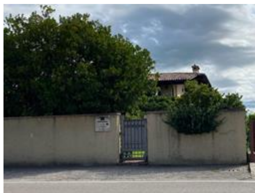
- Veduta generale esterna fabbricato
