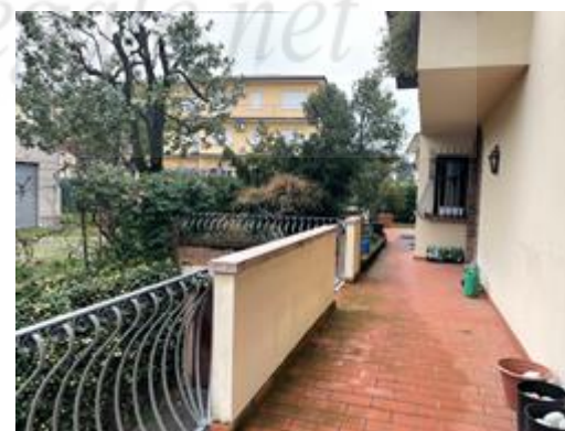
- Veduta generale fabbricato
