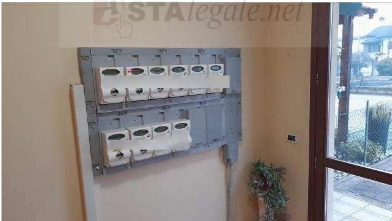
**Figura 29. Contatori elettricità in vano scale condominiale.**
