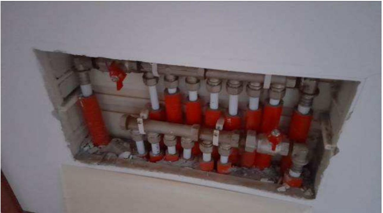
**Figura 26. Collettori impianto di riscaldamento.**
