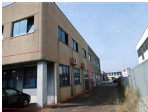
Prospetto – lato nord – con individuazione dell'immobile oggetto di stima
