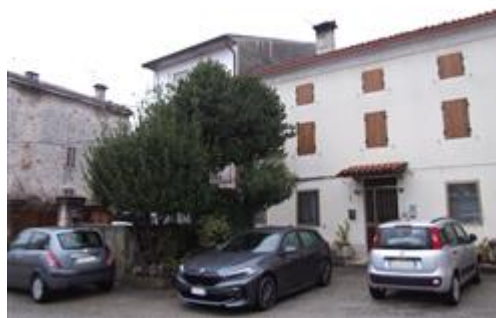
Veduta da Sud-Est
