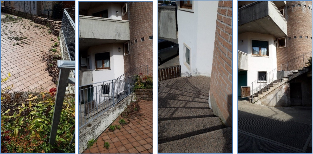
Area lastricata in prossimità della scala (anche m.n. 2710 sub 1), scala collegamento area esterna PT/PIANO "SEMINTERRATO"
