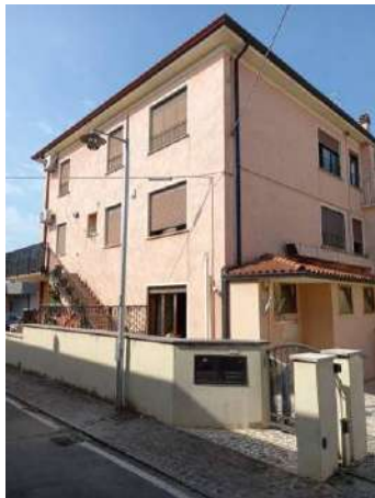
VISTA ESTERNA LATERALE
