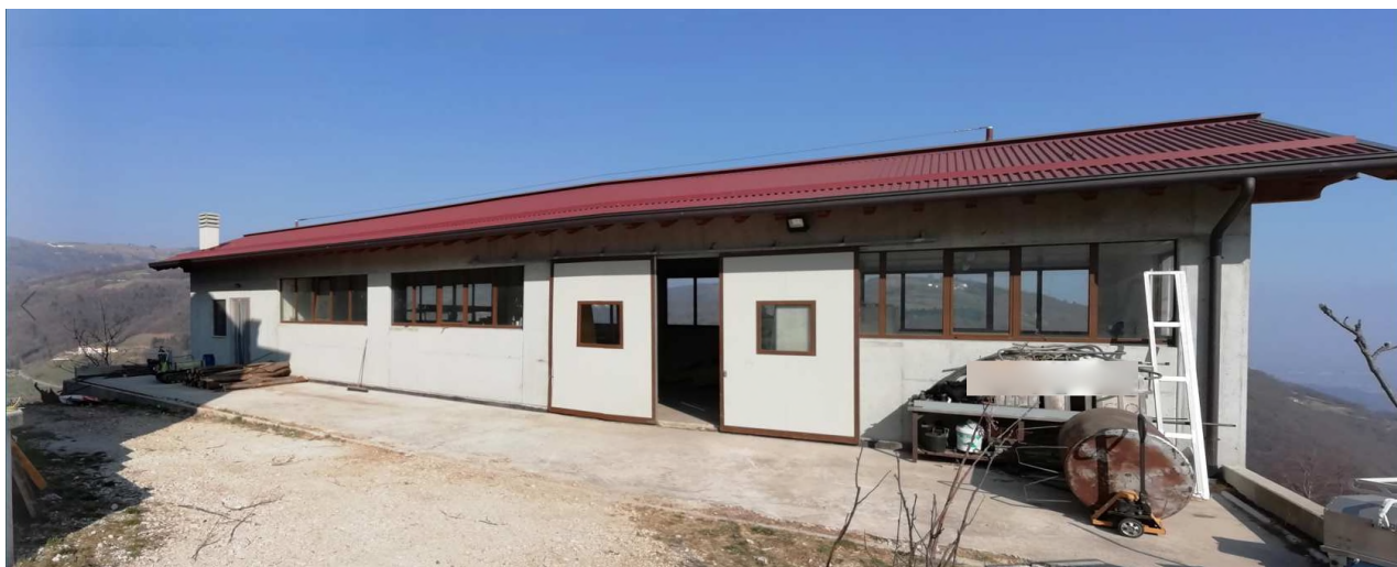
Vista ovest – piano terra
