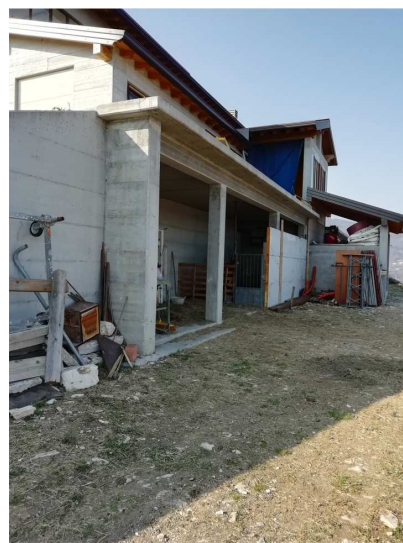
Vista est – locali abusivi
