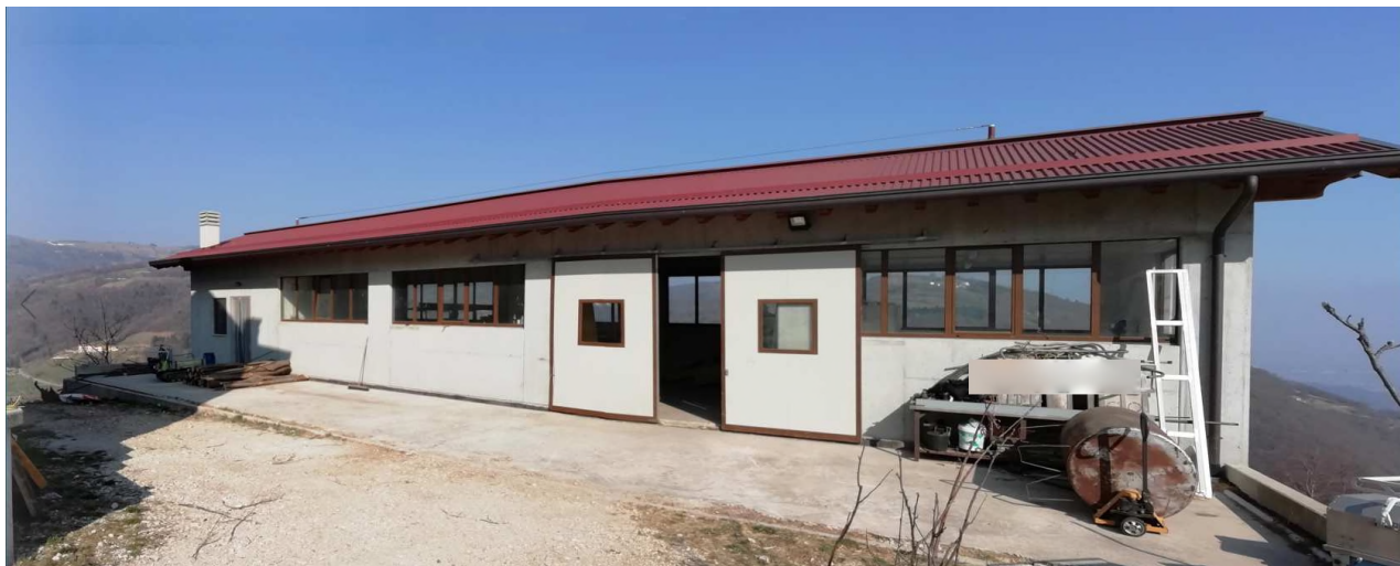
Vista ovest – piano terra
