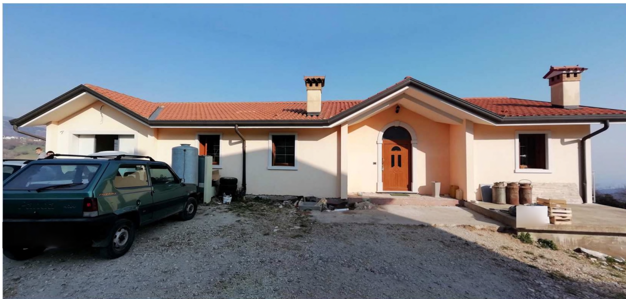
Vista facciata ovest abitazione
