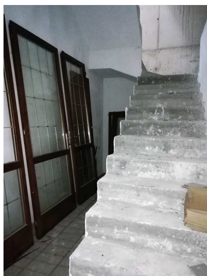
Scala di accesso dal seminterr.
