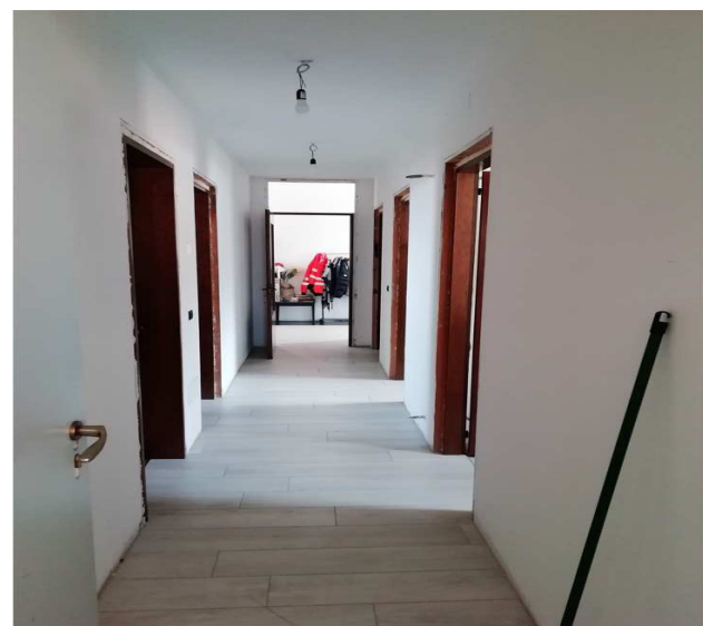
Vista corridoio (finitura infissi da completare)
