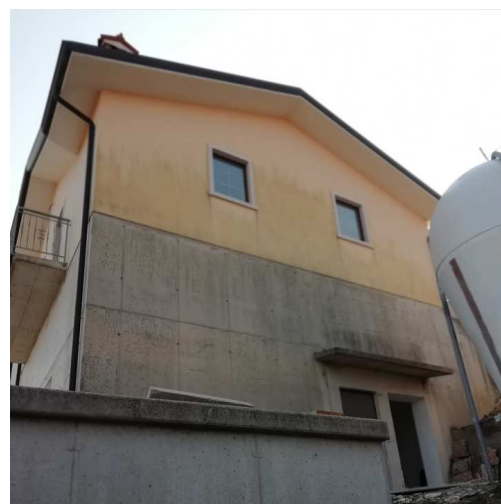
Vista facciata nord
