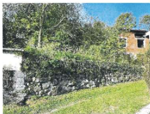
Esterno – accesso al fabbricato
