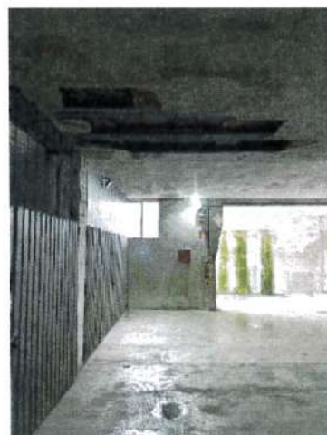
Piano interrato area comune
