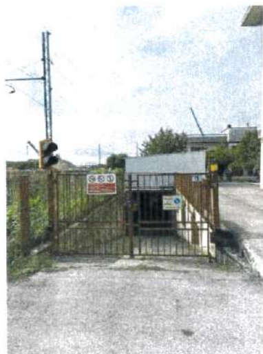
Esterno, accesso carraio
