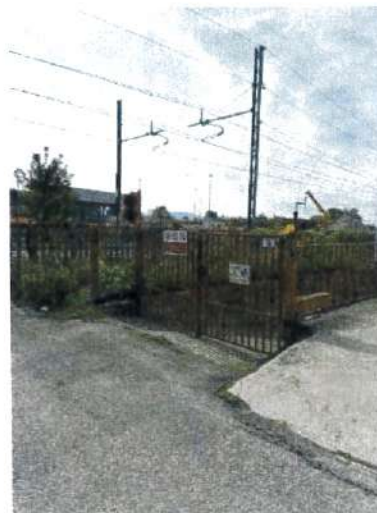
Esterno, accesso carraio
