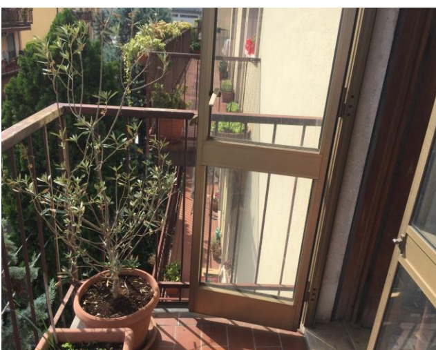
- Particolare serramenti verso sud
