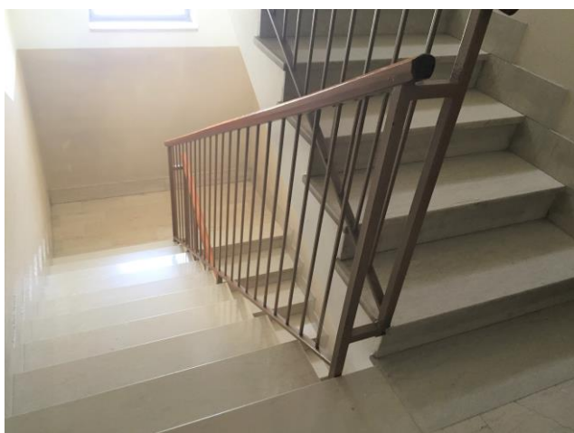
- Veduta scala condominiale interna
