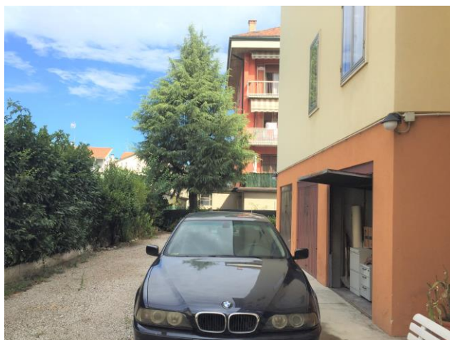
- Veduta esterno retro, verso nord
