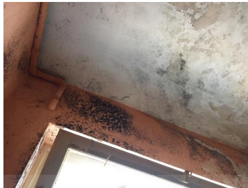
- particolare finestra bagno e soffitto
