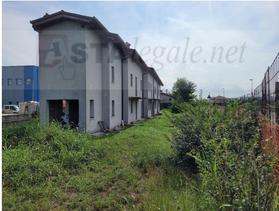
Fabbricato al grezzo, sito in Comune di Caldogno C.T. Fg. 5 particella 237.
