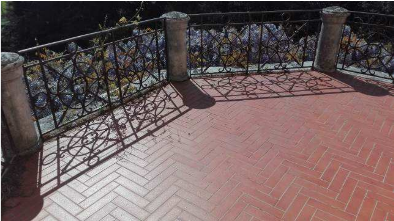
Figura 66. Terrazzo est piano primo.
