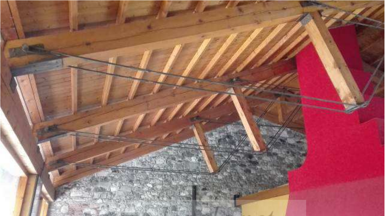
Figura 49. Vista interna ex stalla.
