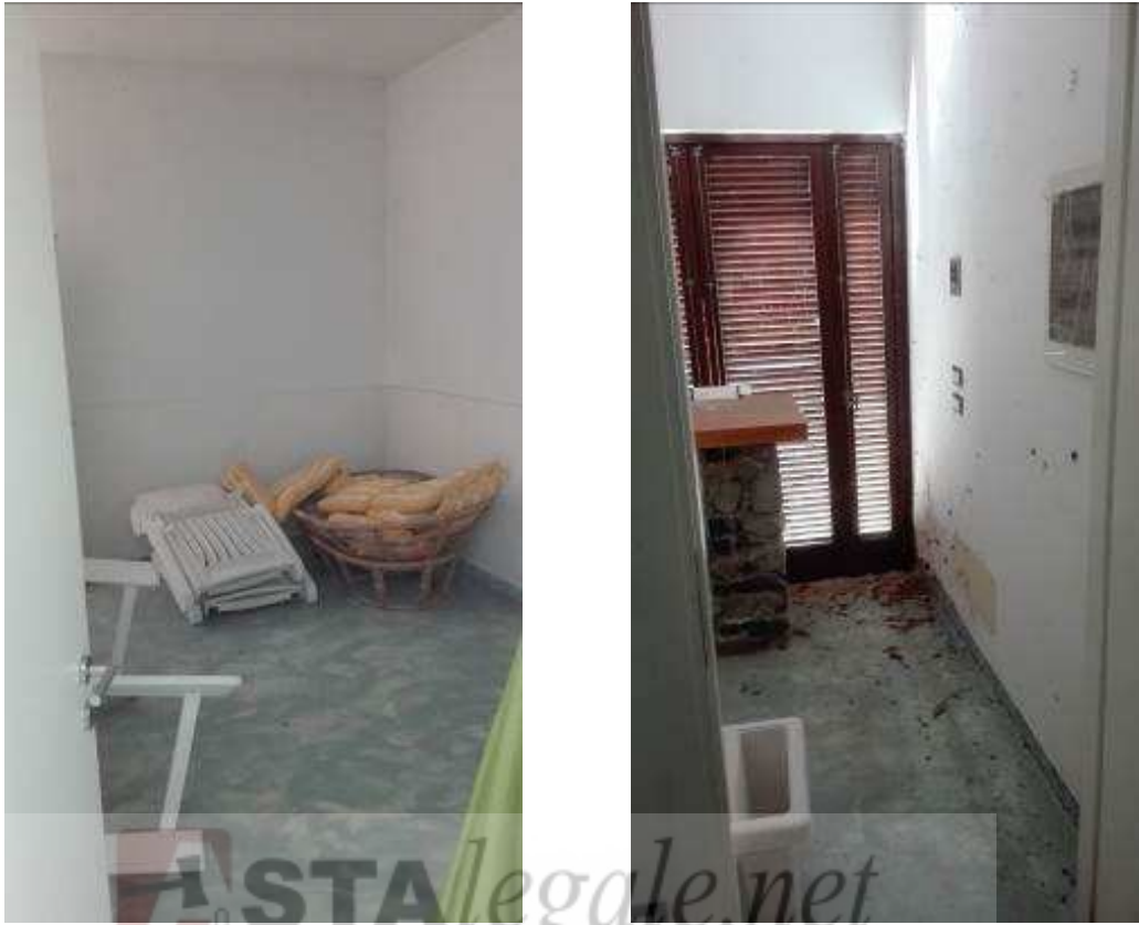
Figura 107. Locali accessori piscina.
