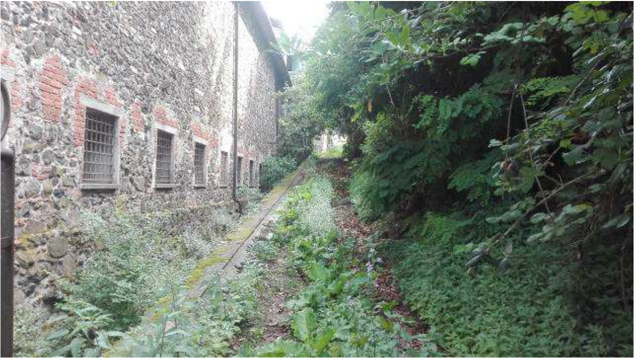
Figura 125. Accesso da Via del Motto.
