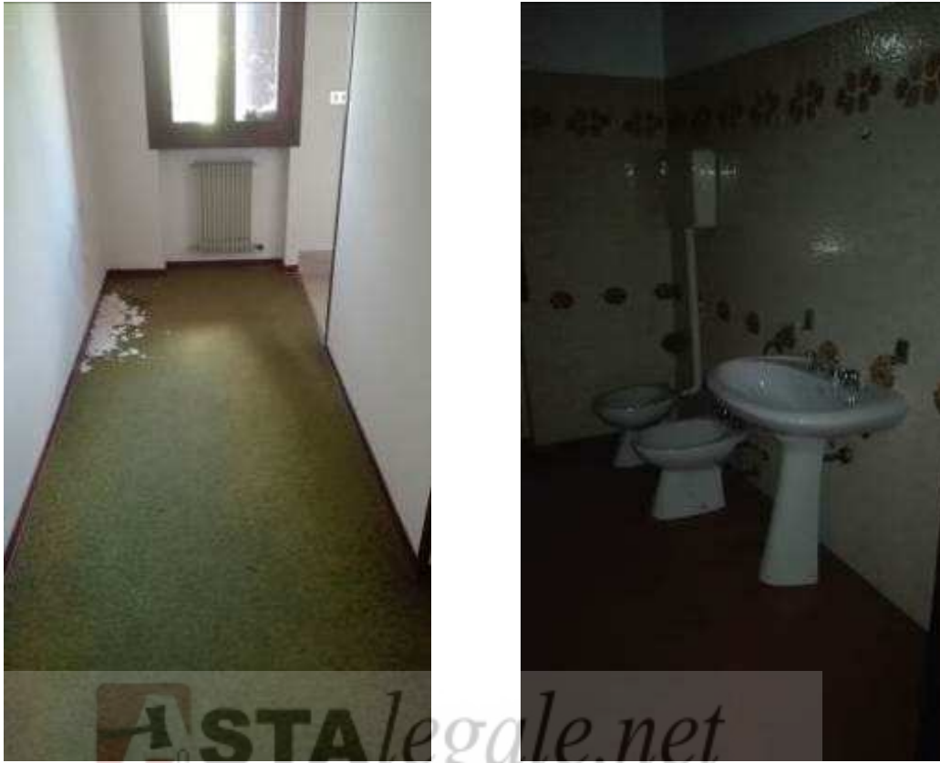
Figura 23. Corridoio e bagno p.p..
