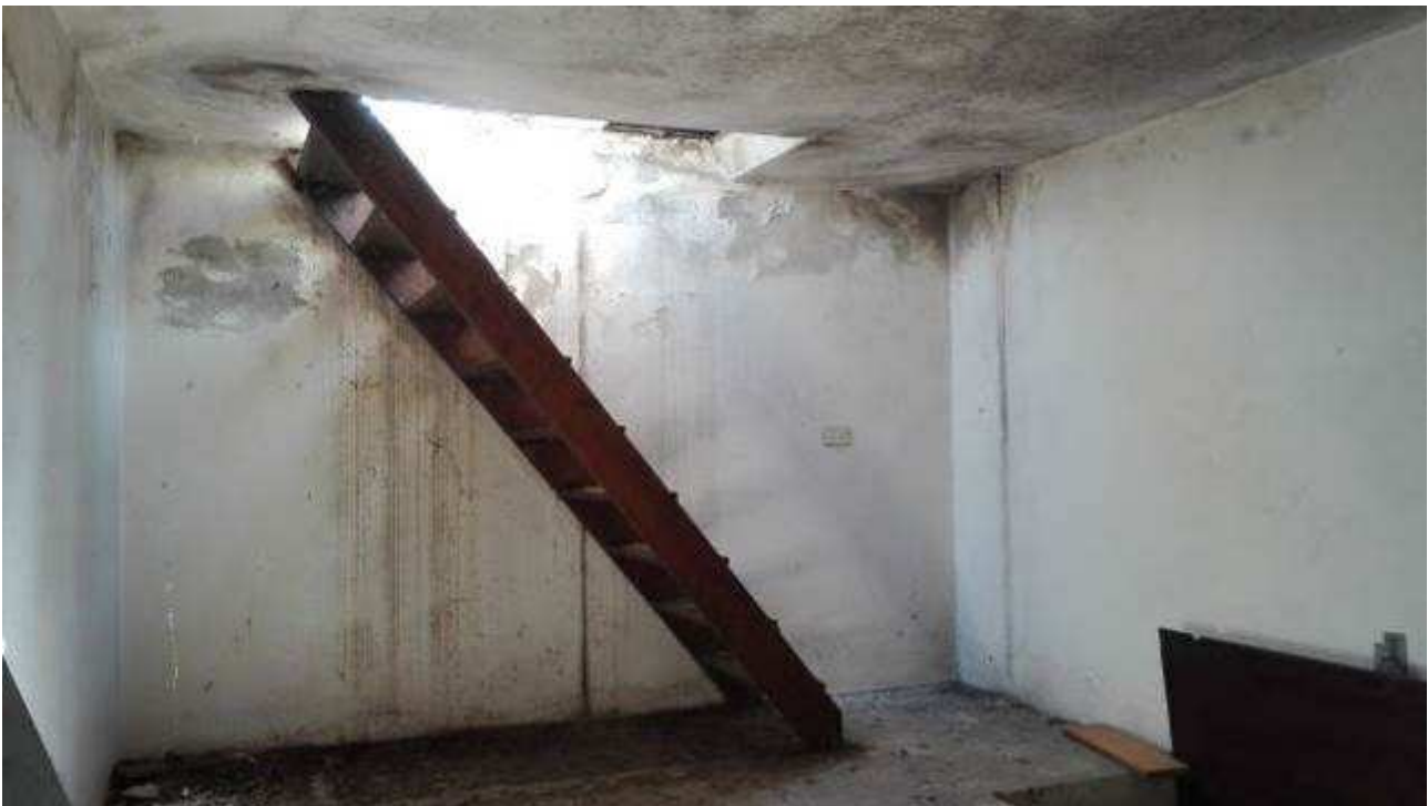
Figura 84. Vista interna locali piano terzo.
