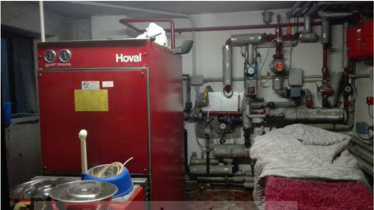
Figura 55. Vista locali piano interrato.
