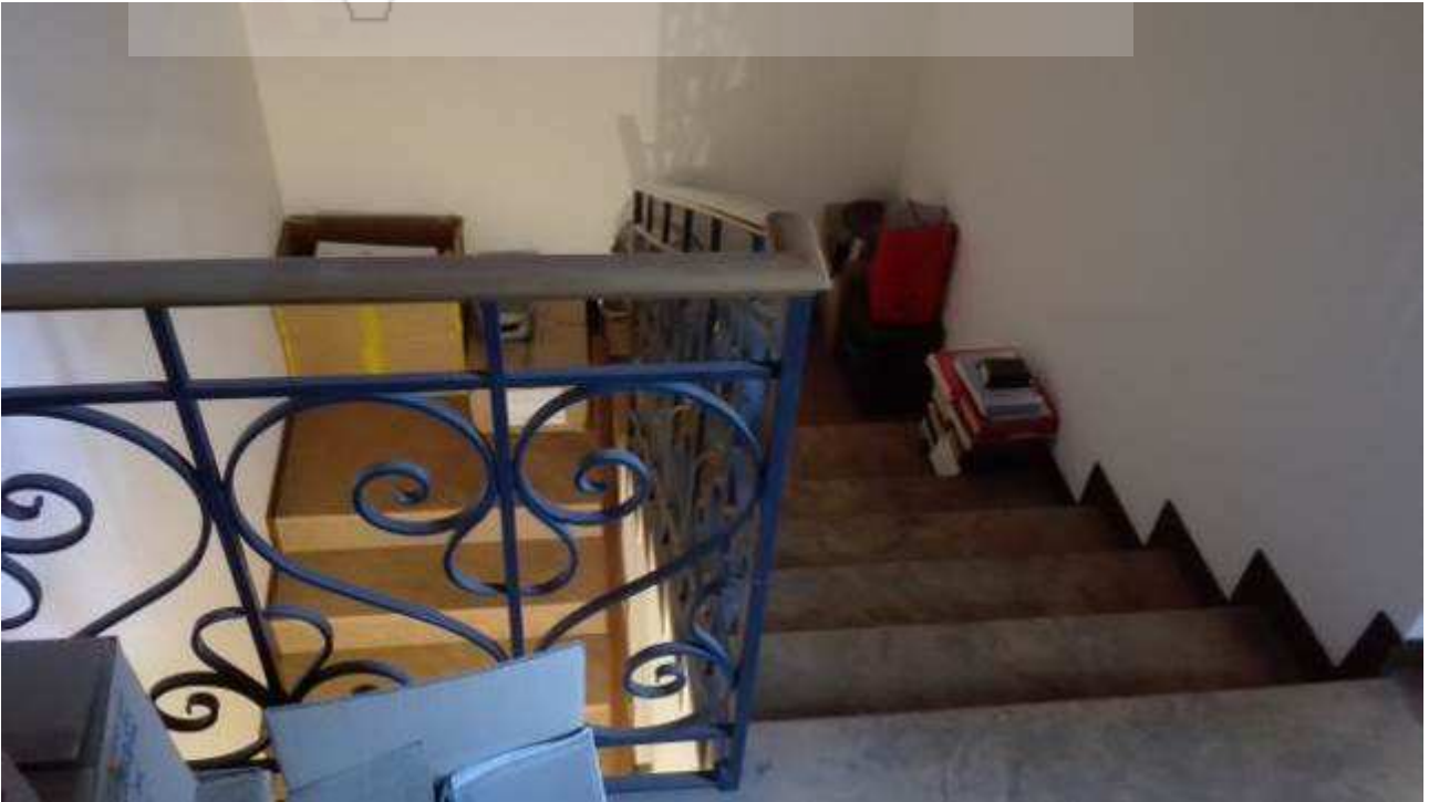
Figura 74. Scala ovest accesso soffitte.
