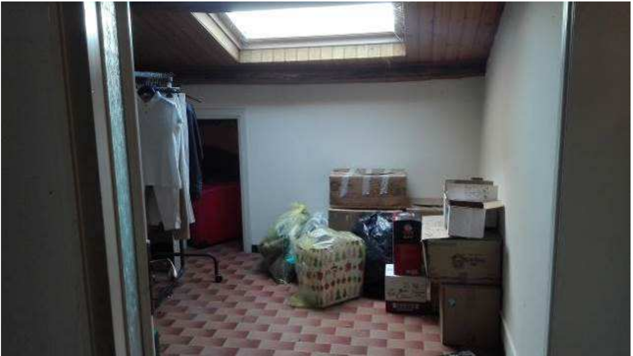
Figura 76. Soffitte zona ovest piano secondo.
