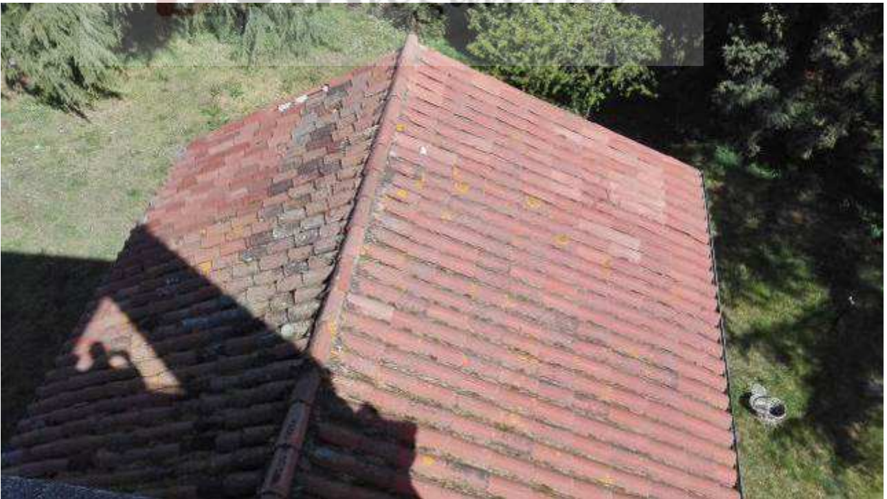
Figura 88. Copertura ripostigli n-e.
