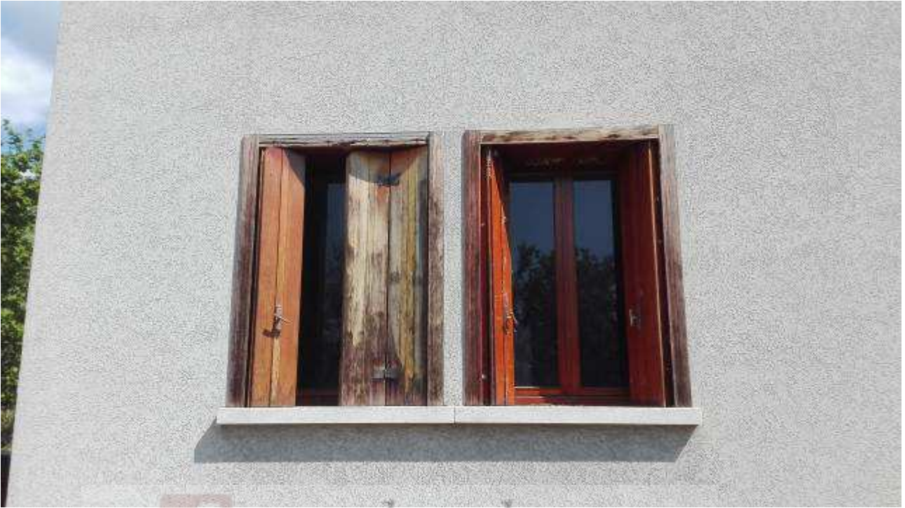
Figura 29. Infissi ammalorati.
