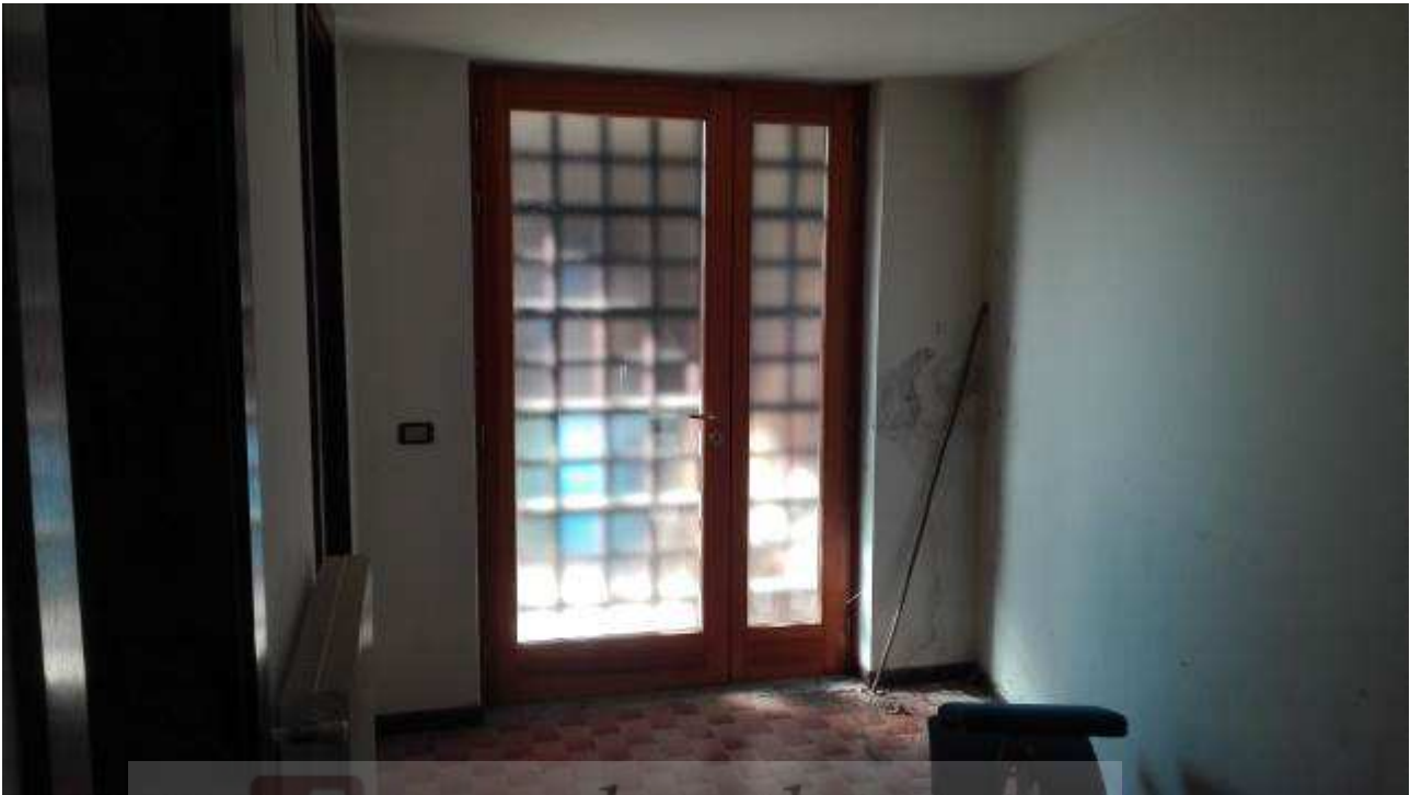
Figura 57. Vista locali piano interrato.
