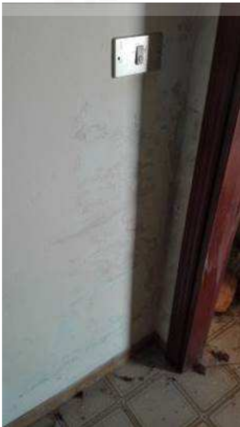
Figura 28. Segni infiltrazioni umidità.
