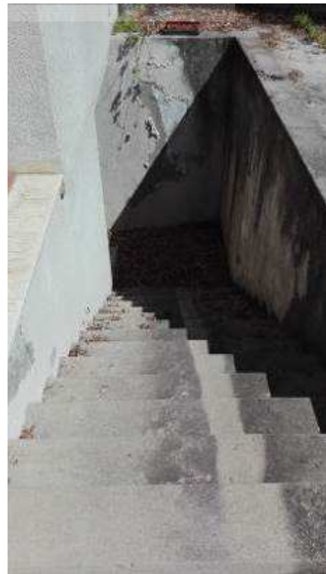
Figura 28. Segni infiltrazioni umidità.
