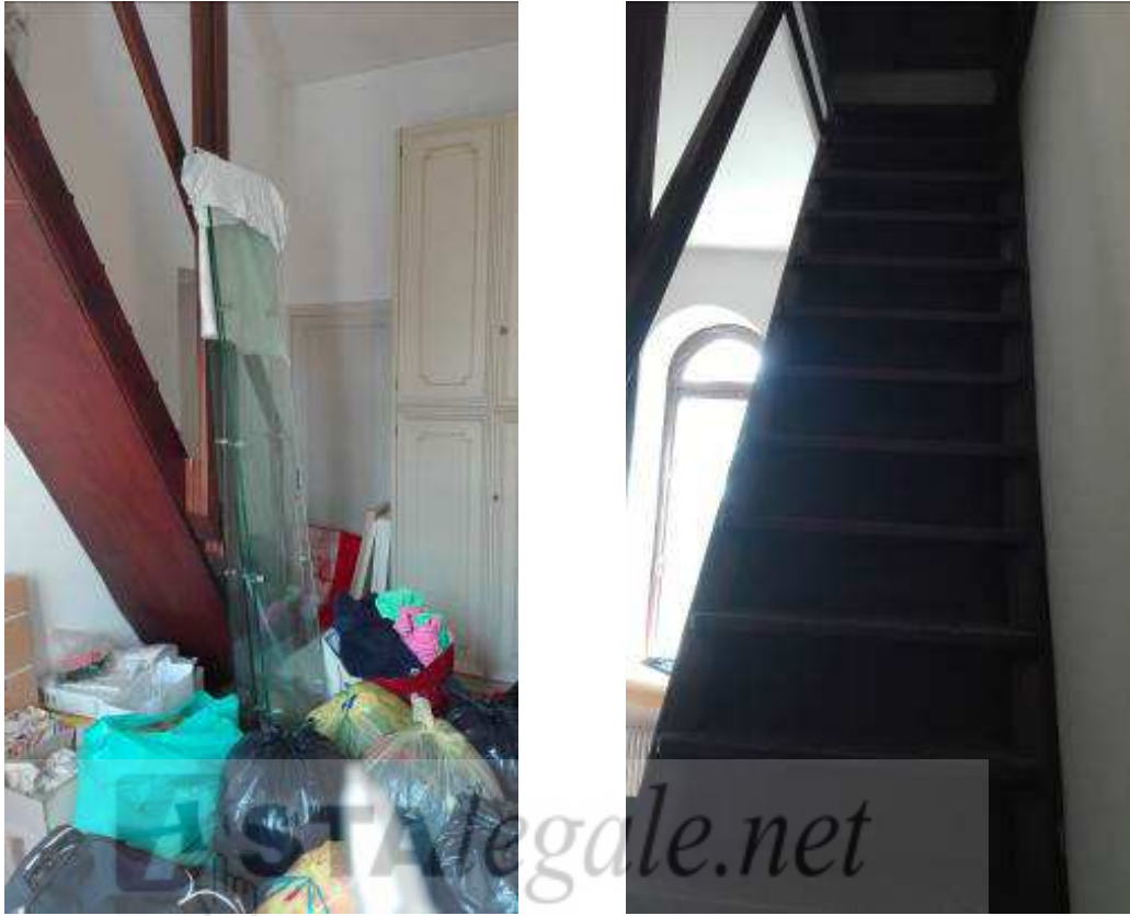
Figura 83. Vista interna locali piano secondo.
