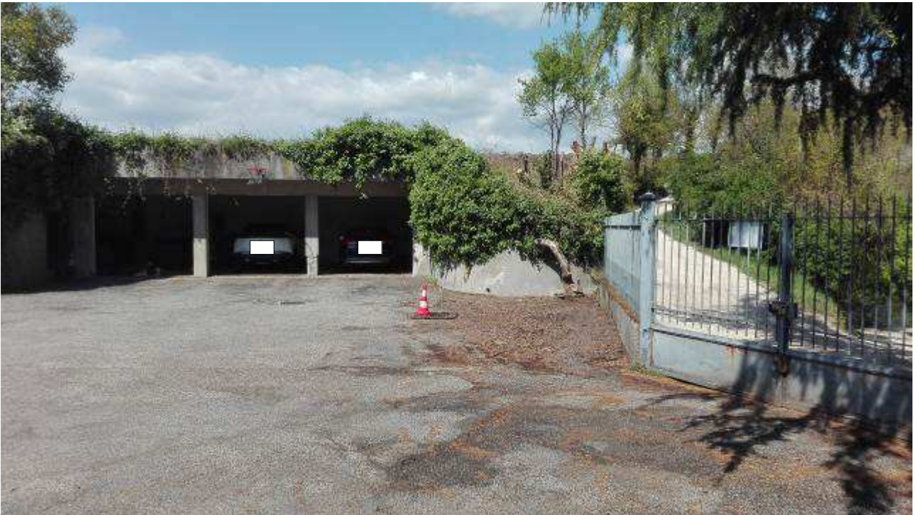
Figura 116. Vista est, e chiusini cisterne nel piazzale.
