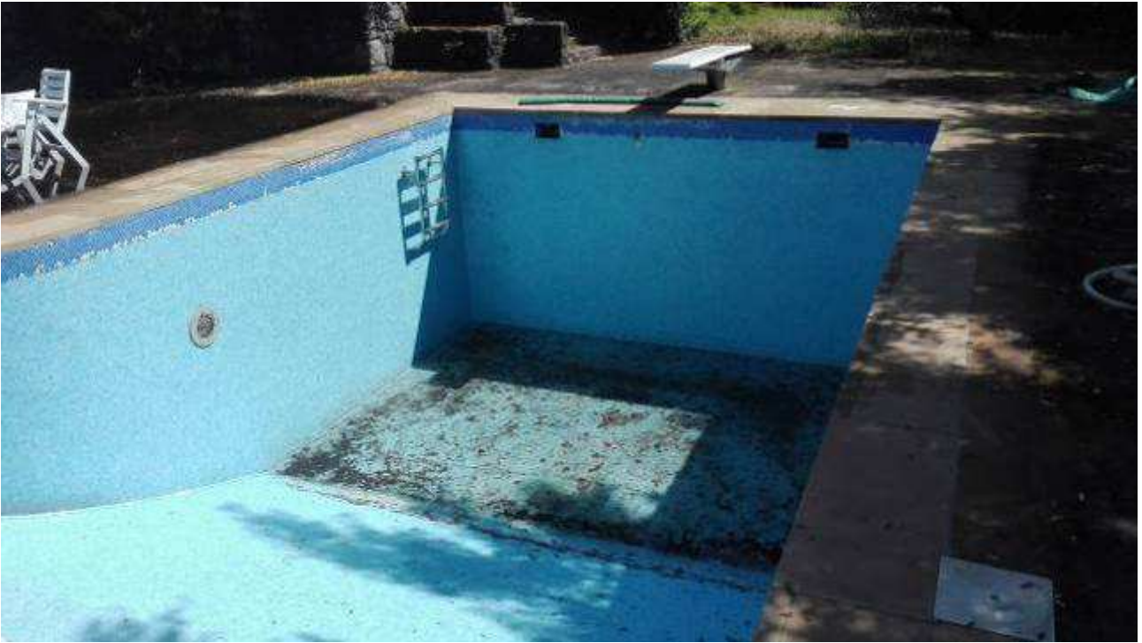
Figura 105. Vista da ovest.
