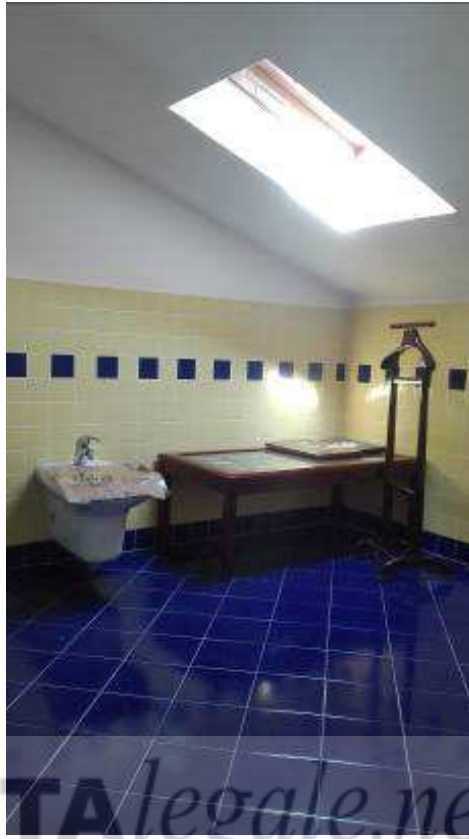
Figura 75. Soffitte zona ovest piano secondo.
