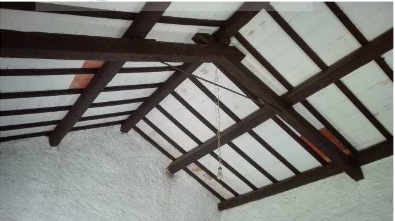
Figura 100. Copertura ripostigli n-e.
