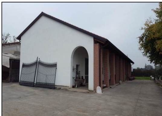
Vista esterna da sud-ovest
