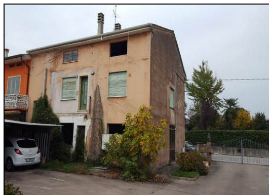
Vista esterna da sud-est
