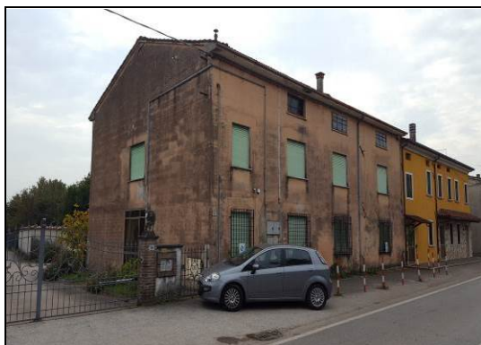
Vista esterna da nord-est
