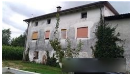
Vista generale da Nord-Ovest
