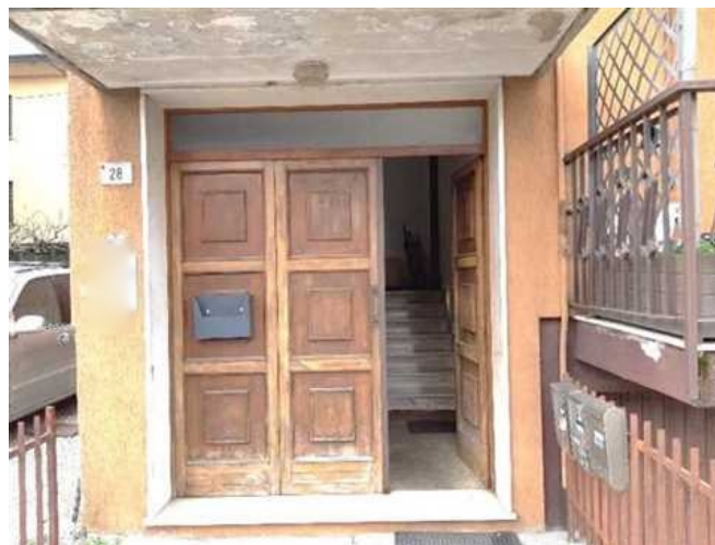
Vista dell'ingresso alla scala comune
