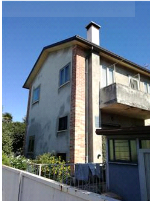
Vista esterna da sud ovest.
