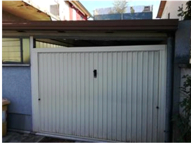
Vista esterna sull'autorimessa.
