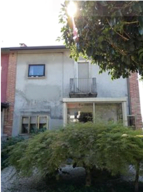
Vista esterna da nord.
