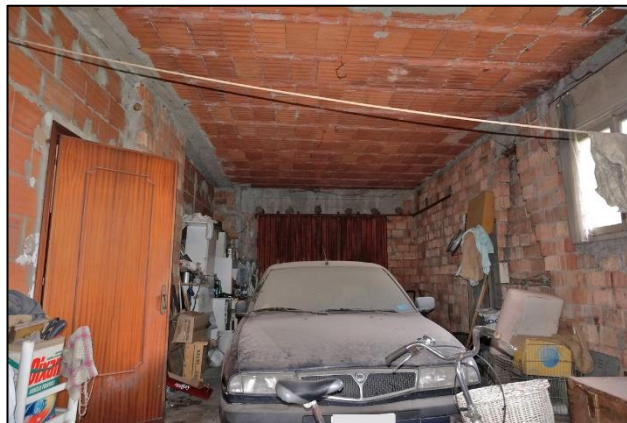
foto 16- Interno del garage
