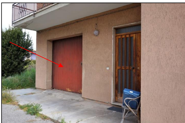
foto 15 - Portone di ingresso al garage sub 13
