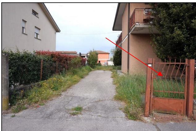
foto 9 - Cancelli pedonale su Via D. Alighieri
