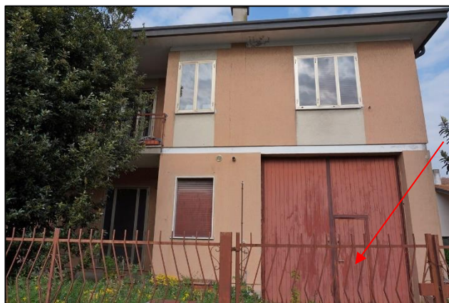
foto 10 - Cancelli carraio e portone del garage sub 9
