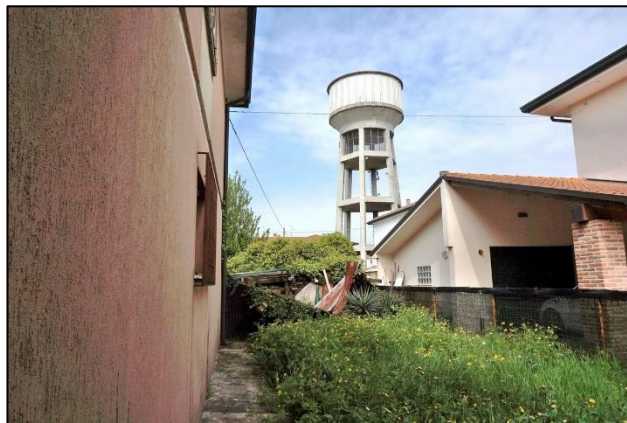
foto 20- vista dal lato Nord
