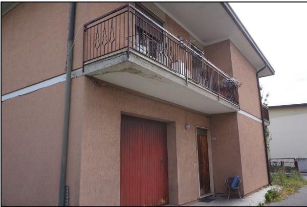
foto 3 - Lato Sud con il portoncino di ingresso
