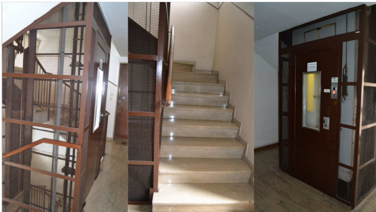
Figure 12-13-14- Vano scale condominiale e ascensore
